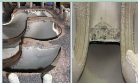
Пример точечной коррозии
