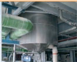
Механическое удаление ржавчины и сушка внутренних поверхностей
