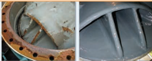
Поврежденный дроссельный клапан – до и после ремонта
