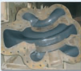
Корпус после ремонта
