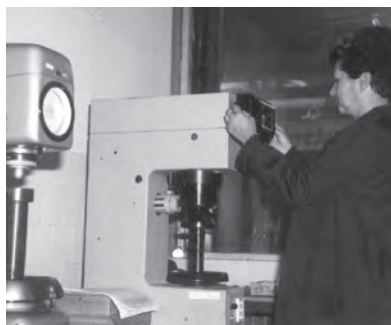
Рис.3 Измерение твердости
